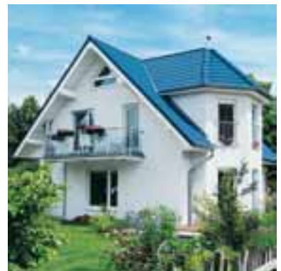
Fenster sind dominante Gestaltungselemente.
